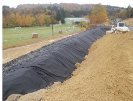
Figure 6 : Localisation et vue de la pose du géotextile de séparation
