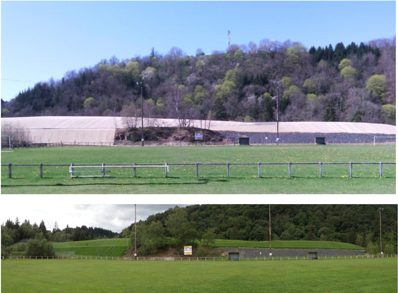
Figure 10 : Ouvrage en fin de travaux avec sa couverture finale de géofilet (14/04/2014) et après mise en végétation (20/08/2014)
