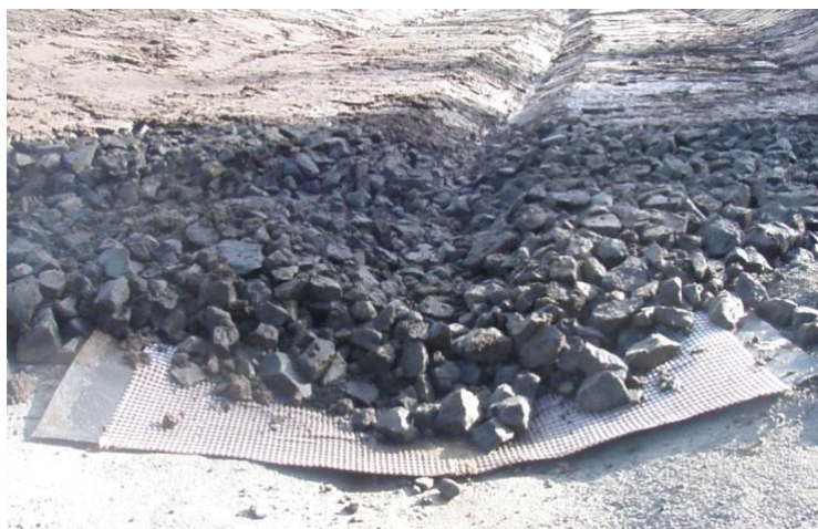
Figure 7. Vue de la pose du géocomposite d'étanchéité anti-érosion de fossé
