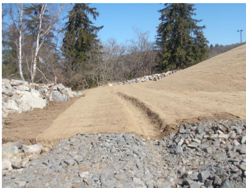
Figure 8. Vue de la pose du géofilet
