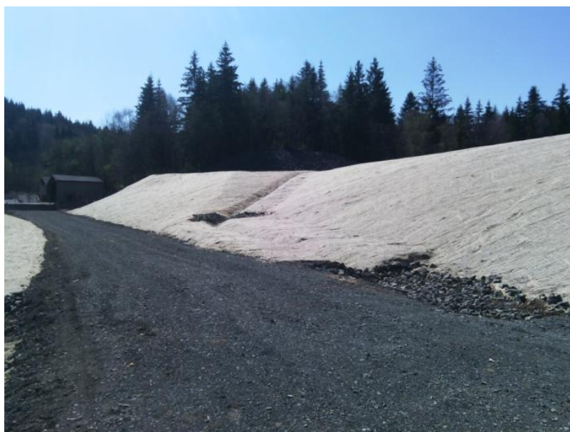
Figure 9. Ouvrage en fin de travaux
